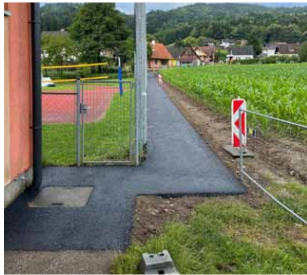
neuer Fußgängerübergang über den Wonischbach und Gehweg in Richtung Mittelschule
